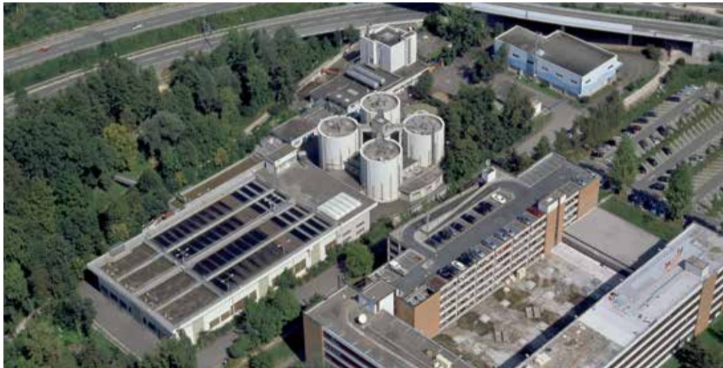
Abwasserreinigungsanlage ARA Neugut (150'000 EW)
